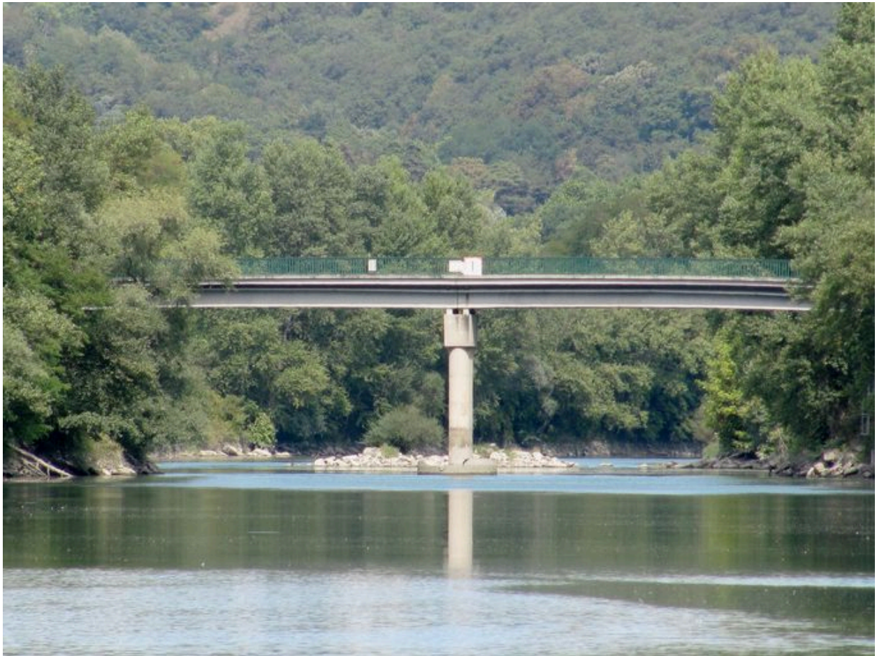
Vue générale, face aval (depuis le lieu-dit les Bardelières)
