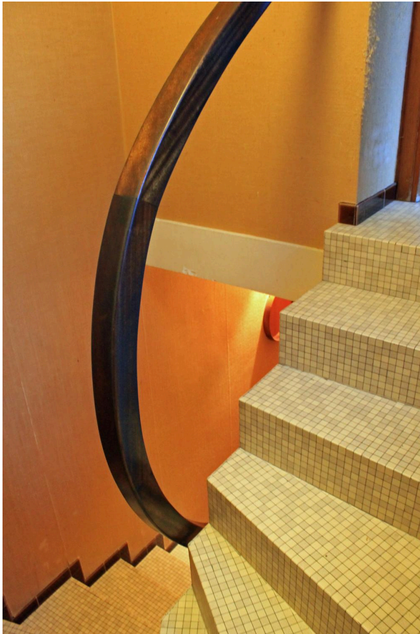
Ceyrat, la maison L., vue partielle de l'escalier intérieur, marches revêtues de mosaïque et main courante en bois.
