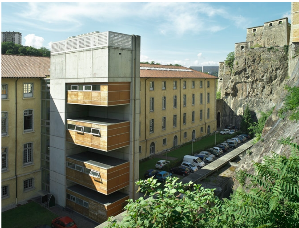
Vue d'ensemble est.
