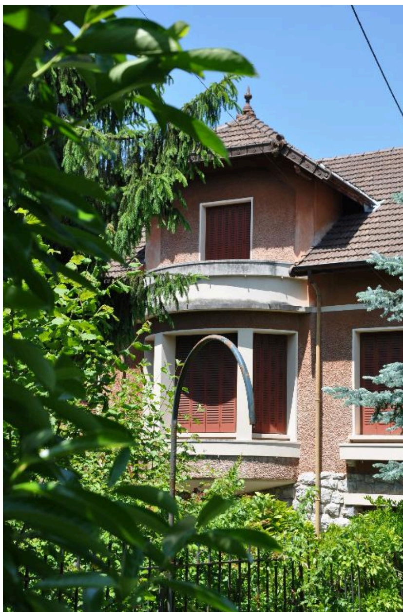
Travée centrale: lucarne-pignon et bow-window
