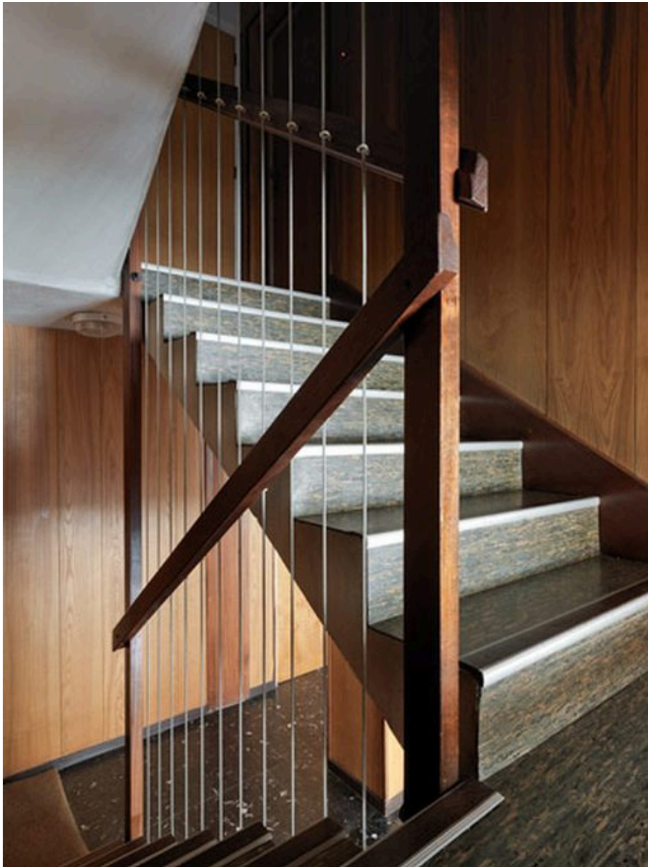
Escalier de l'immeuble
