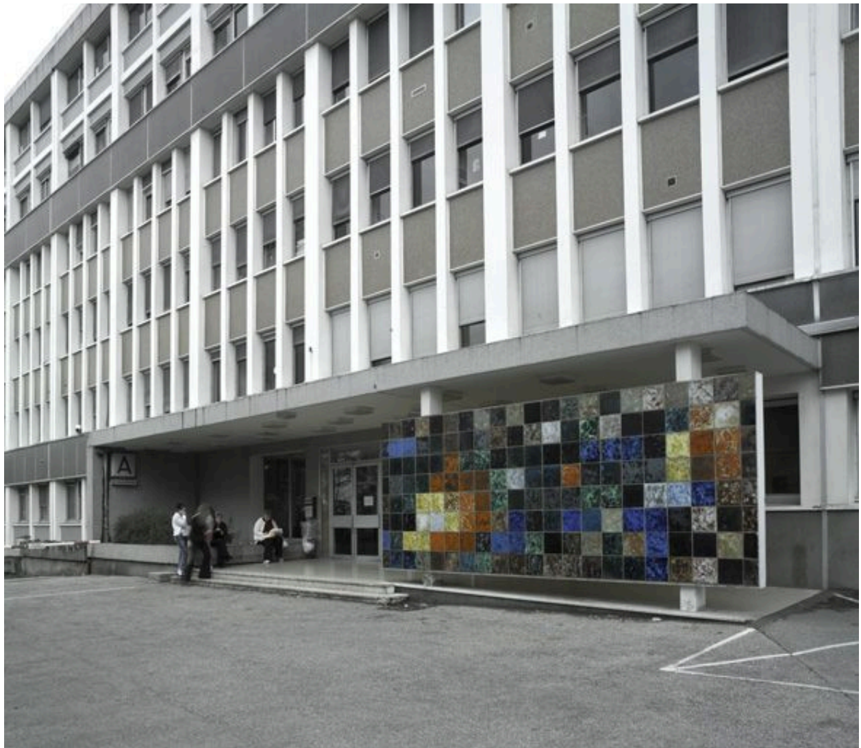
Bpatiment A, façade principale, détails des revêtements mural et du porche
