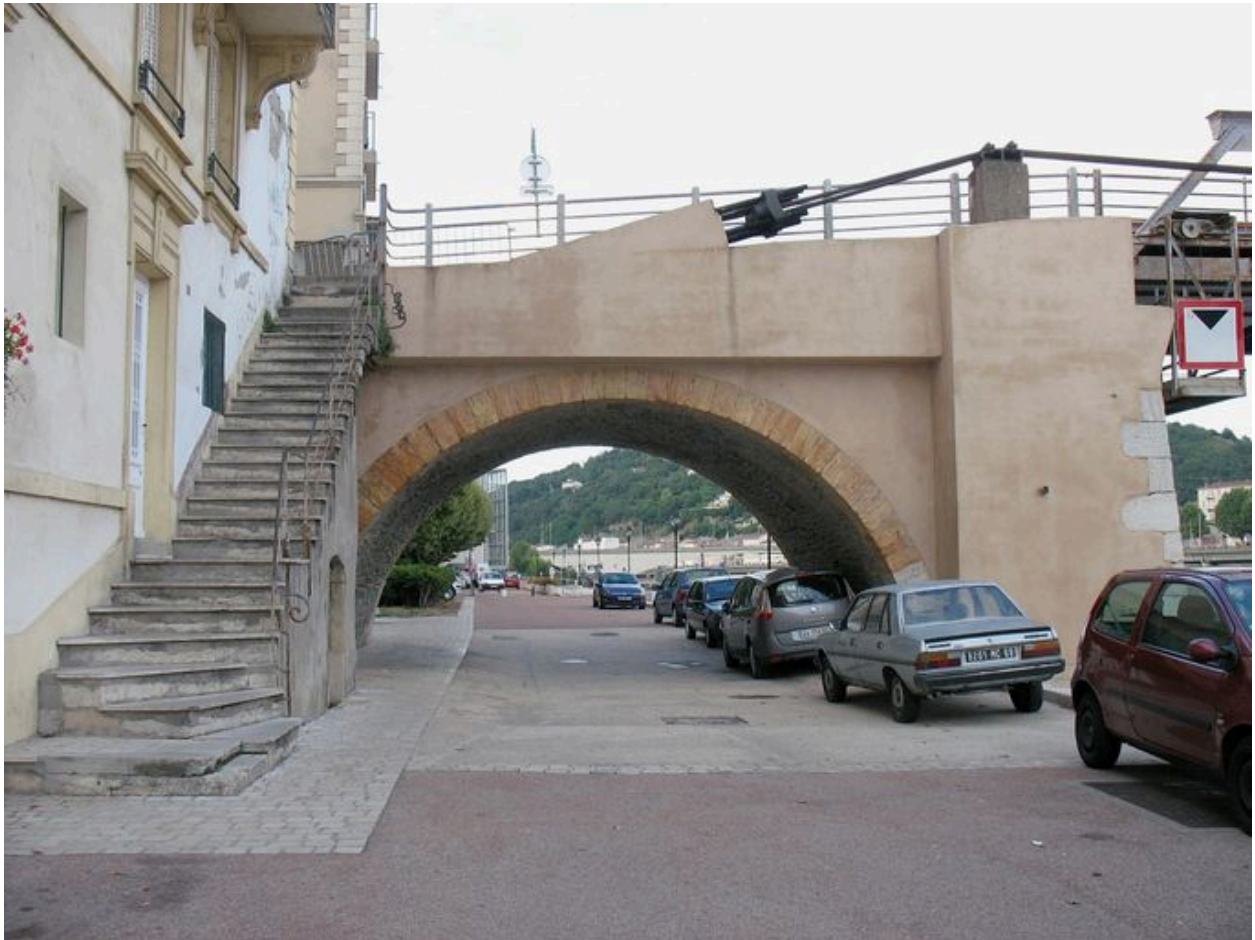
Culée droite, face aval, vue générale : escalier d'accès au quai, arche de rive, câbles et massif d'ancrage (depuis la rive droite)
