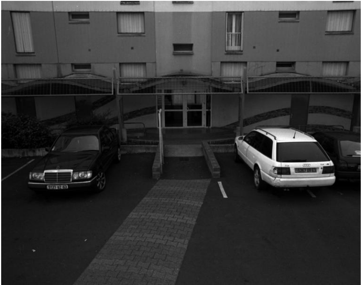
L'une des entrées de l'immeuble aujourd'hui détruit, sur l'élévation postérieure, au nord.
