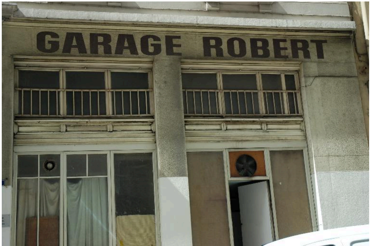
Détail du rez-de-chaussée : l'ancien garage automobile Robert
