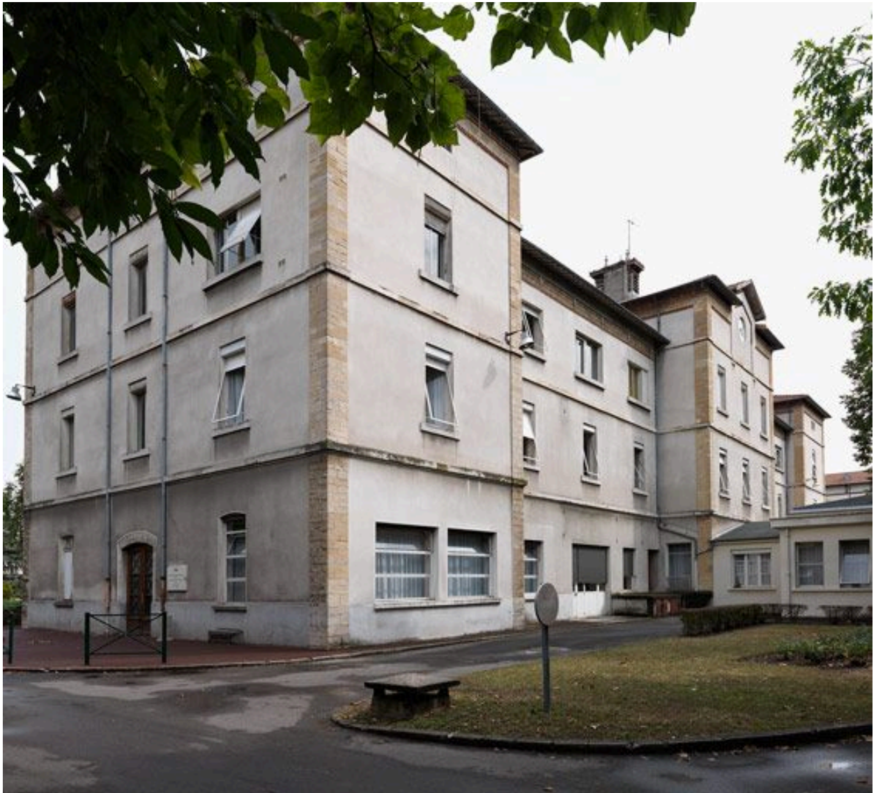
Vue du bâtiment des services généraux depuis le nord-ouest
