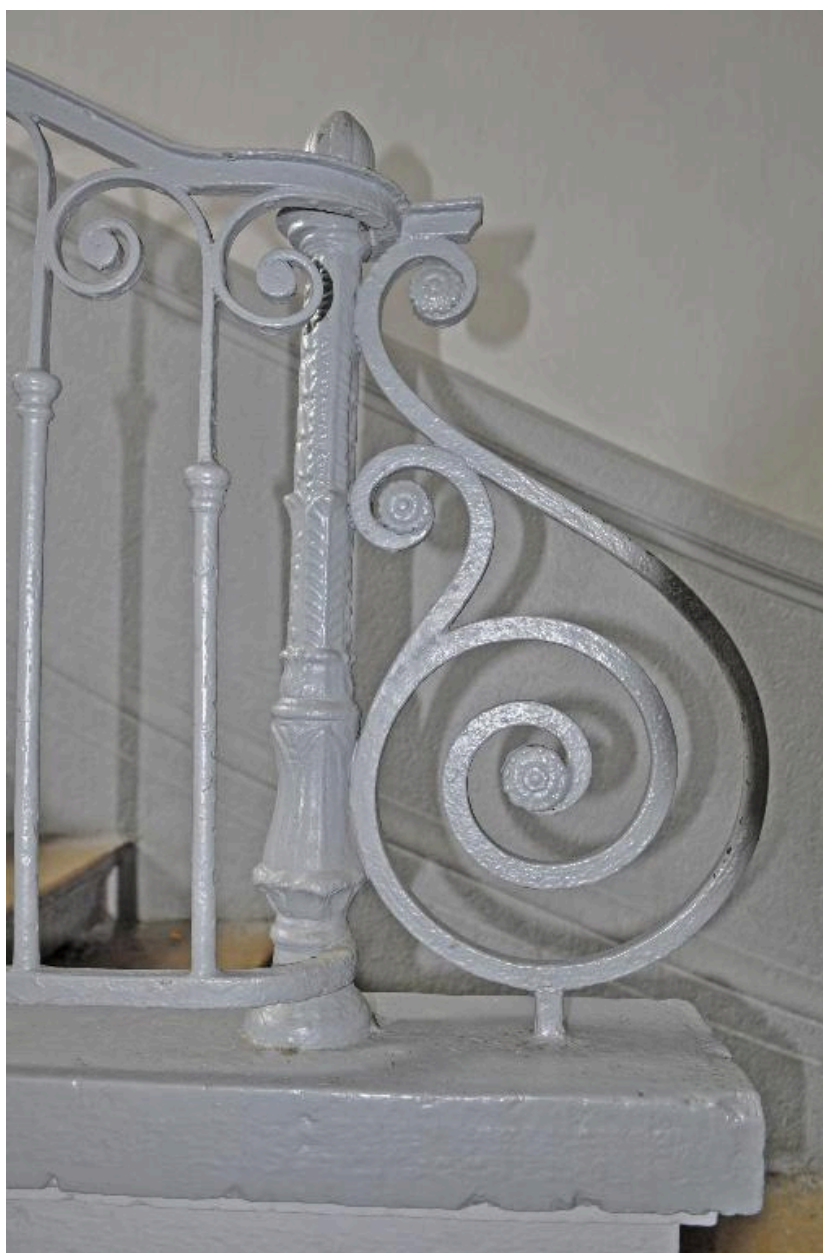
Détail du garde-corps de l'escalier
