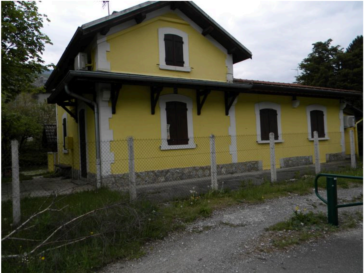
Vue générale de l'ancienne gare.
