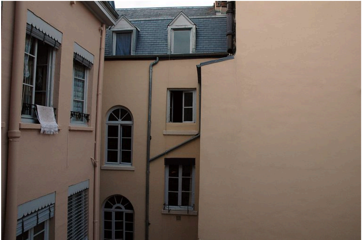
Elévation sur cour : partie supérieure
