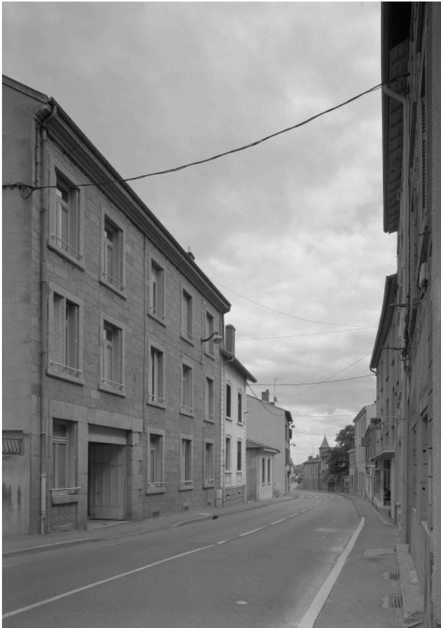
Vue de la rue de Lyon, à hauteur du n°25, du nord.
