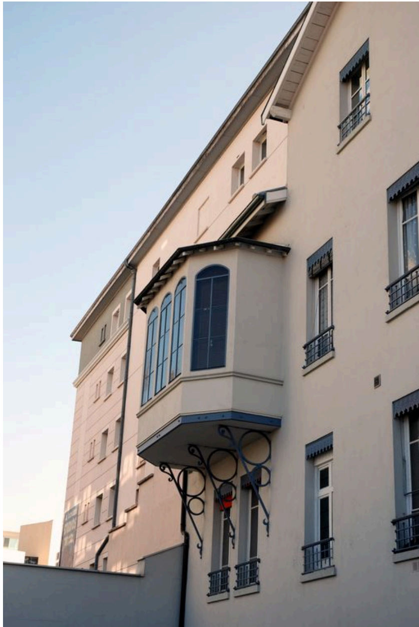
Façade sur cour : détail de l'oriel
