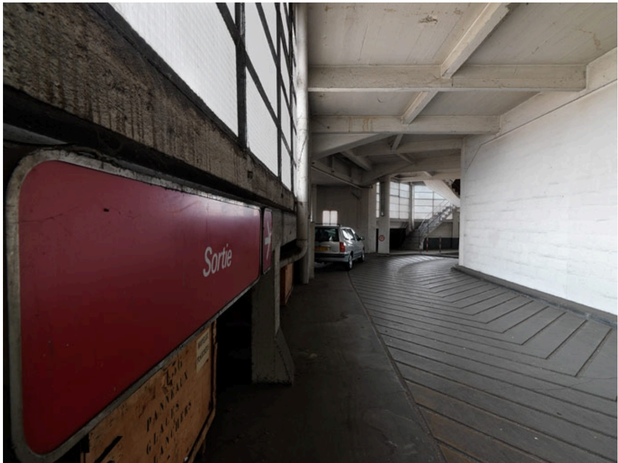
Rampe descendante du 4e au 3e étage
