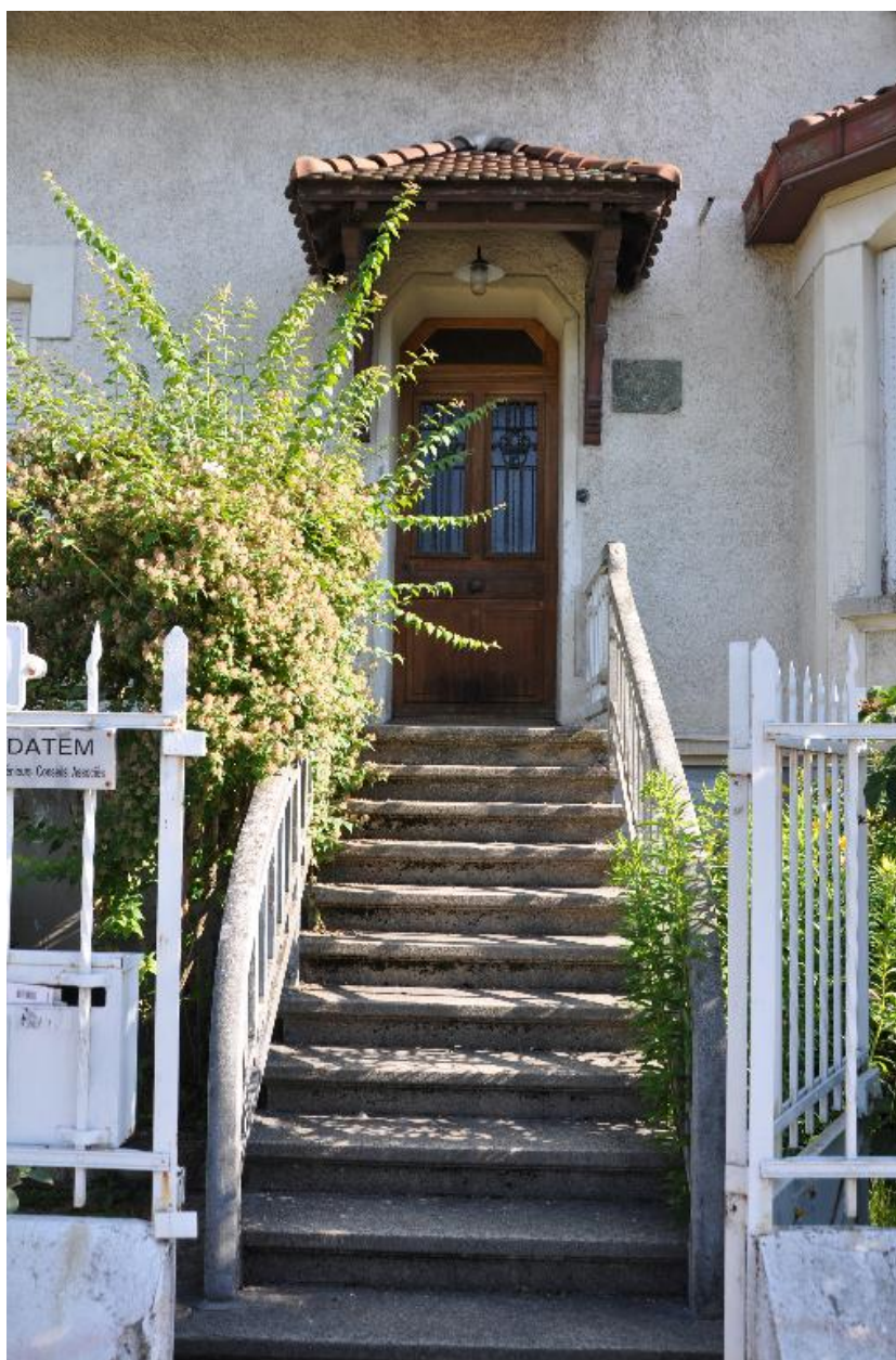
Détail de la porte d'entrée
