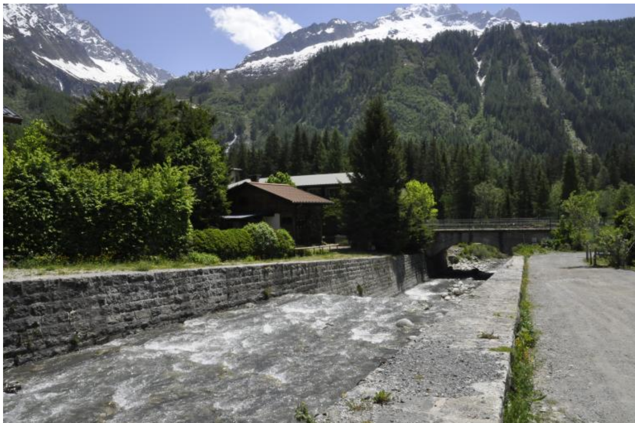
Vue des digues et des seuils canalisant le cours de l'Arve en amont du pont ferroviaire
