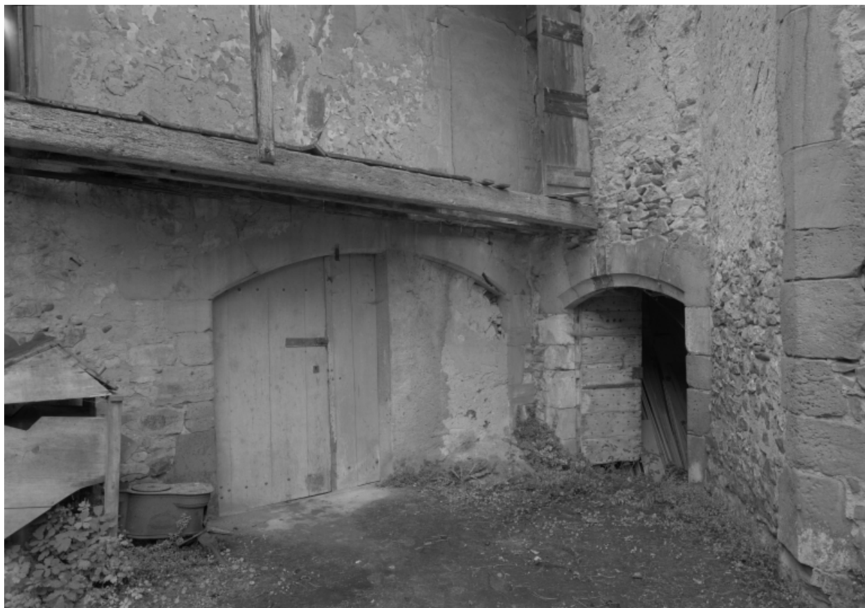
Détail d'élévation : angle interne sud, 1er niveau, aile gauche.
