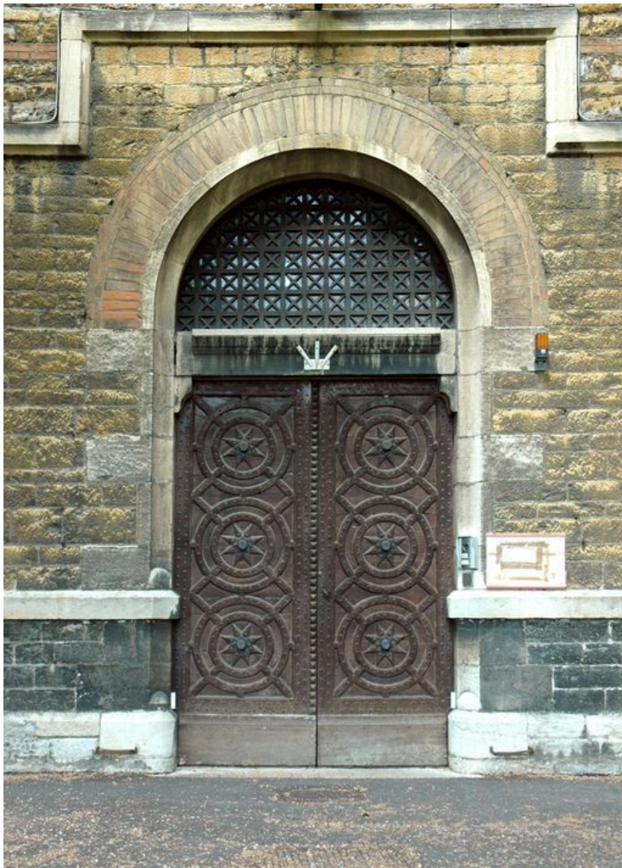
Elévation principale, portail
