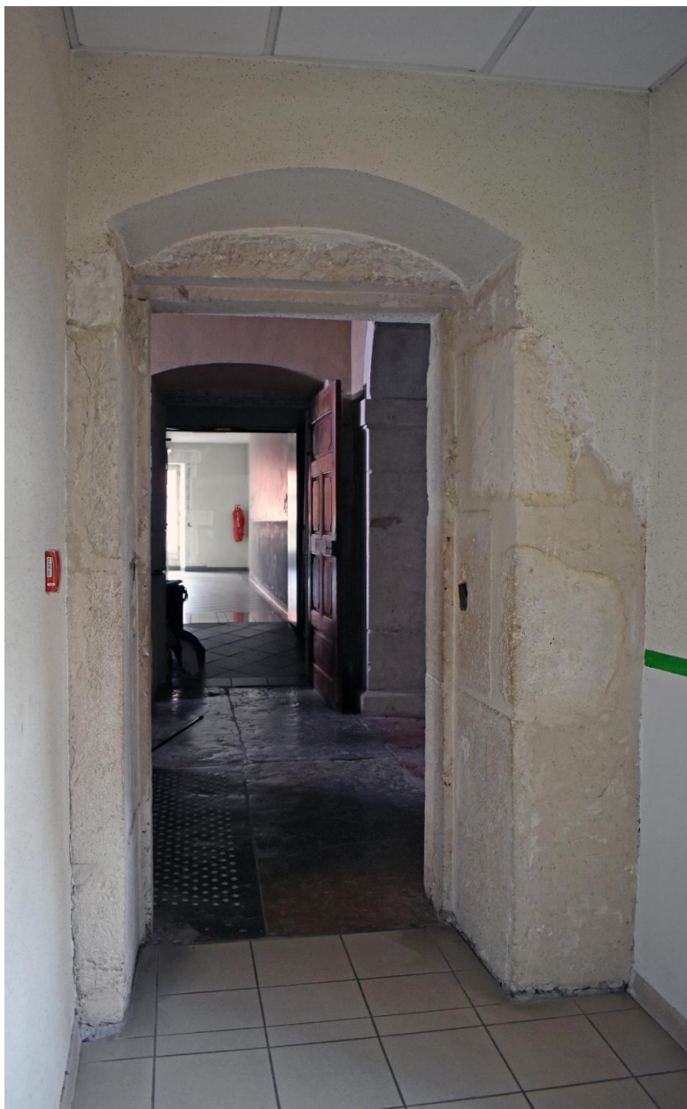
Bâtiment C : palier du 1er étage, porte nord vue depuis le couloir nord
