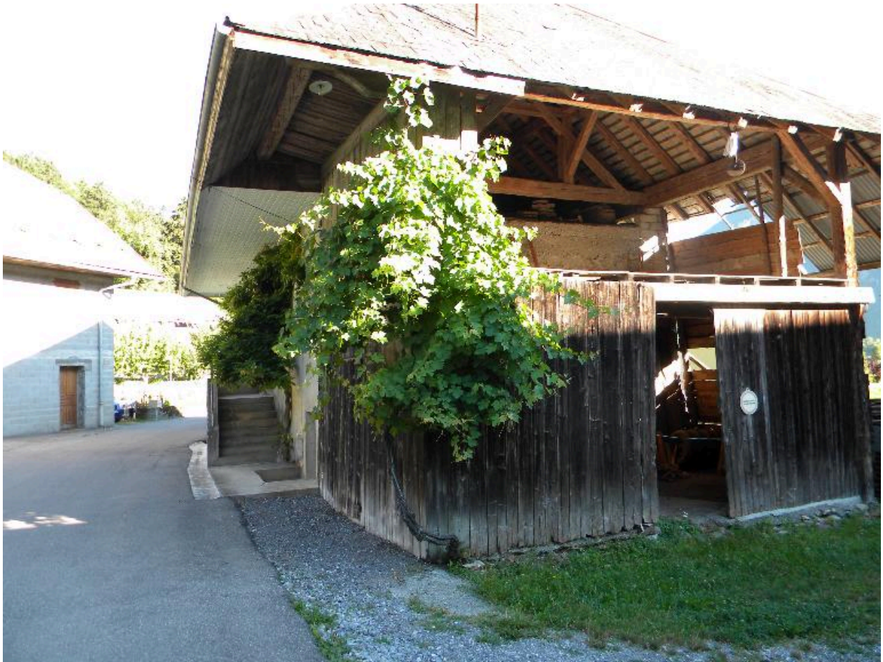
Vue de la remise au bout d'une ferme modifiée (2008 D4 894).
