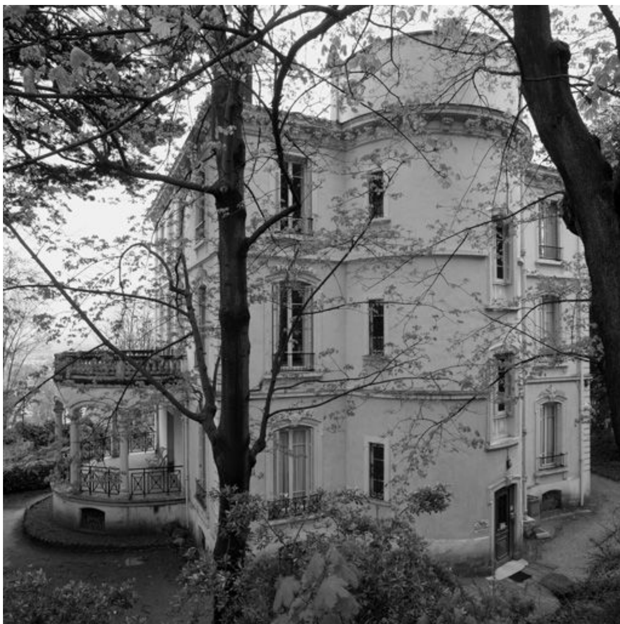
Logis, façade ouest et véranda nord
