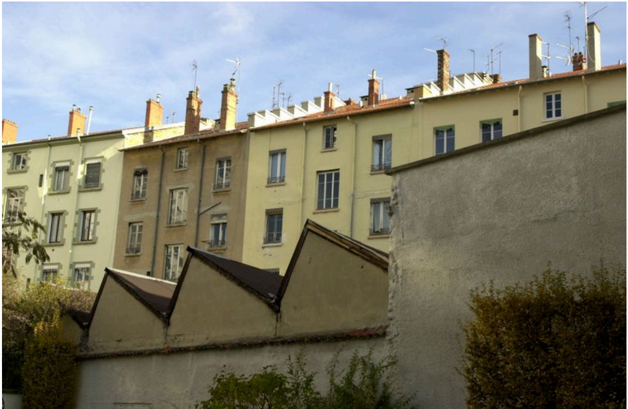
Détail des pignons découverts
