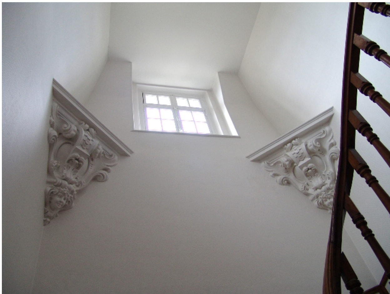
Consoles dans la cage d'escalier
