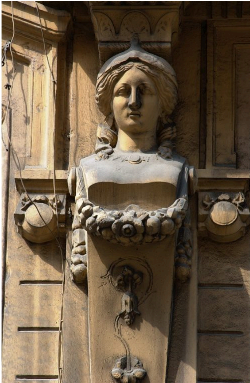
Élévation antérieure : détail de la cariatide engainée
