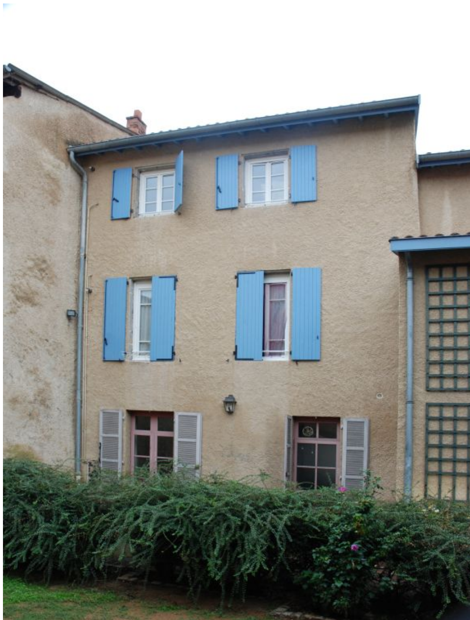
Vue partielle sur cour, partie gauche.
