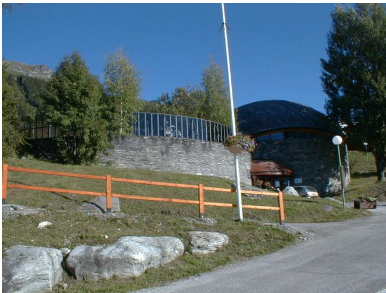
Le chemin d' accès
