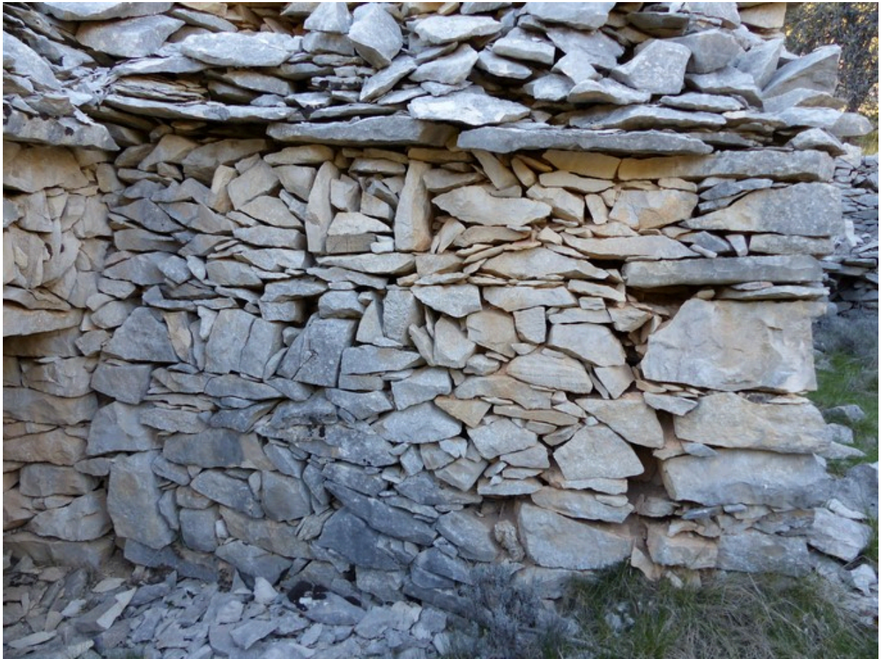
Cabane nord. Élévation est, collage de la maçonnerie.
