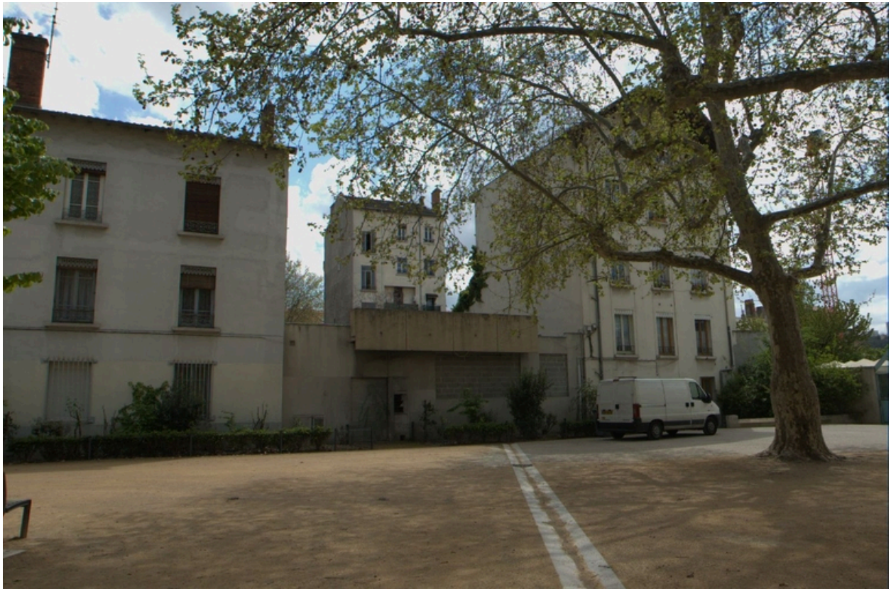
Vue façade nord (arrière) place Ferber
