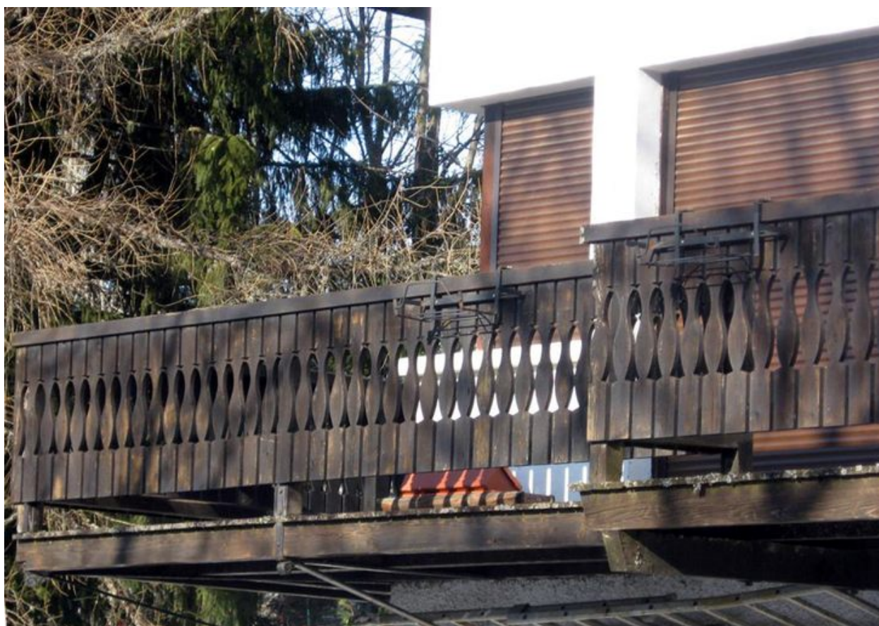
Détail du garde-corps
