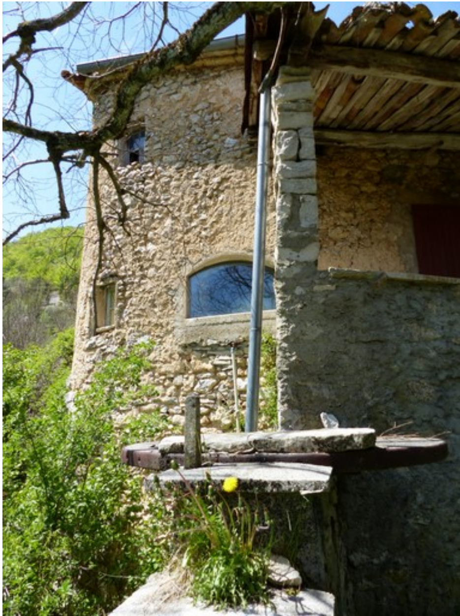
Ensemble occidental. Élévation est, extrémité sud.
