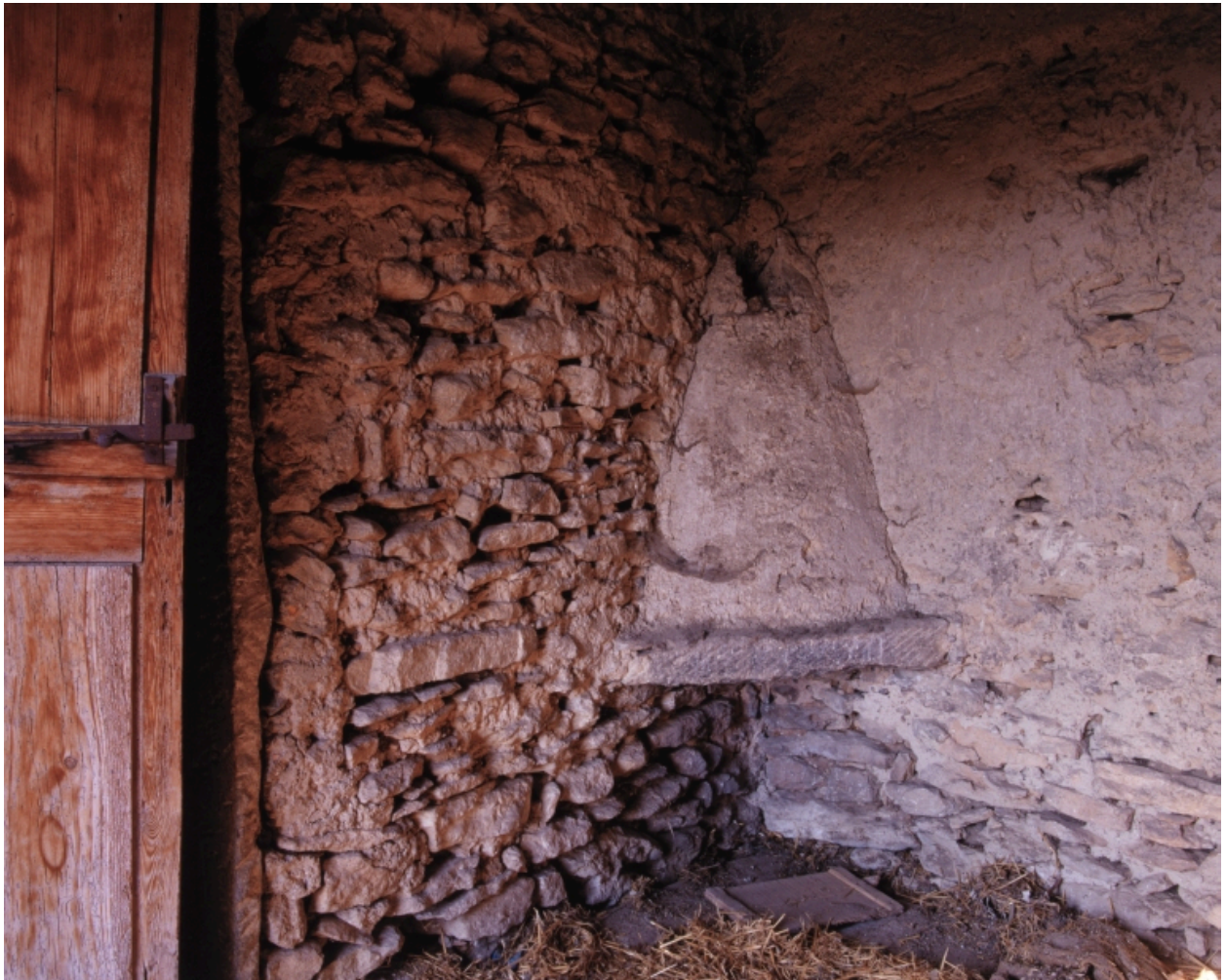
Basses Condaminès, chemin vicinal de Taulignan aux carrières. Ancienne magnanerie - fenil, détail d'une cheminée d'angle.
