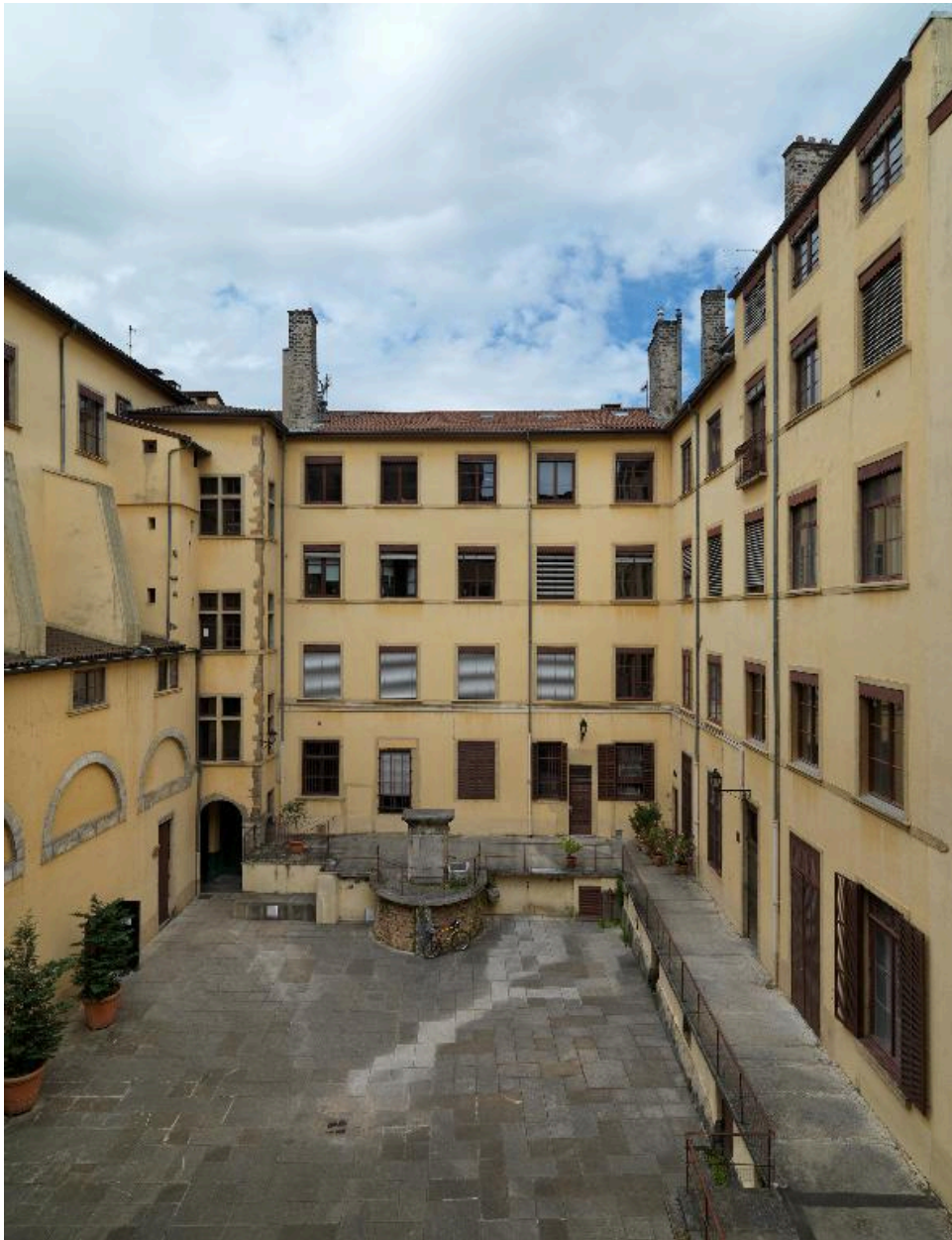
La cour depuis la cage d'escalier de l'immeuble sis à l'est 64 rue Mercière
