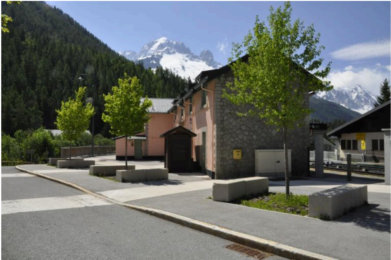
Vue de la de la gare de Montroc-le-Planet située à 70 m au nord-est du viaduc
