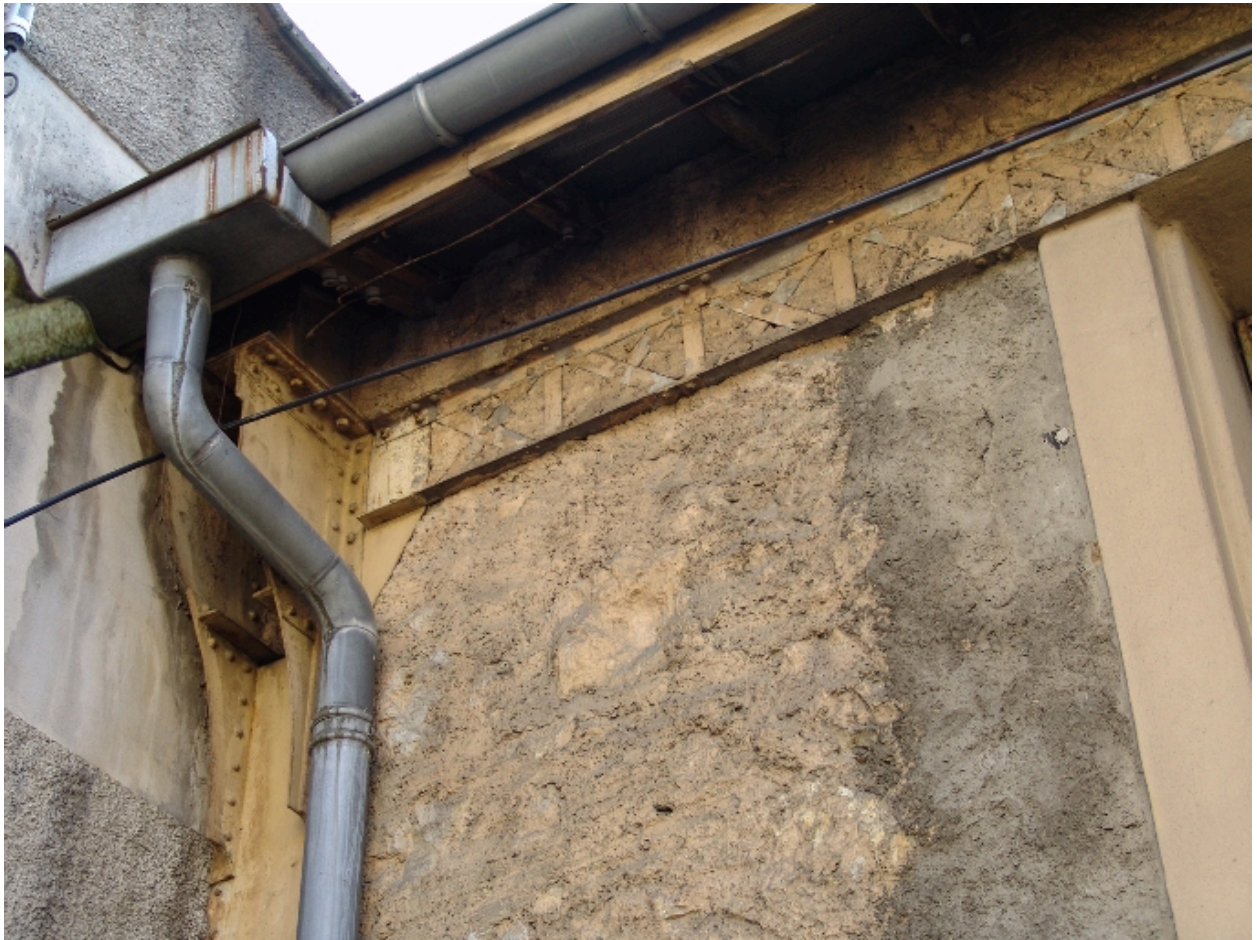
Détail de construction
