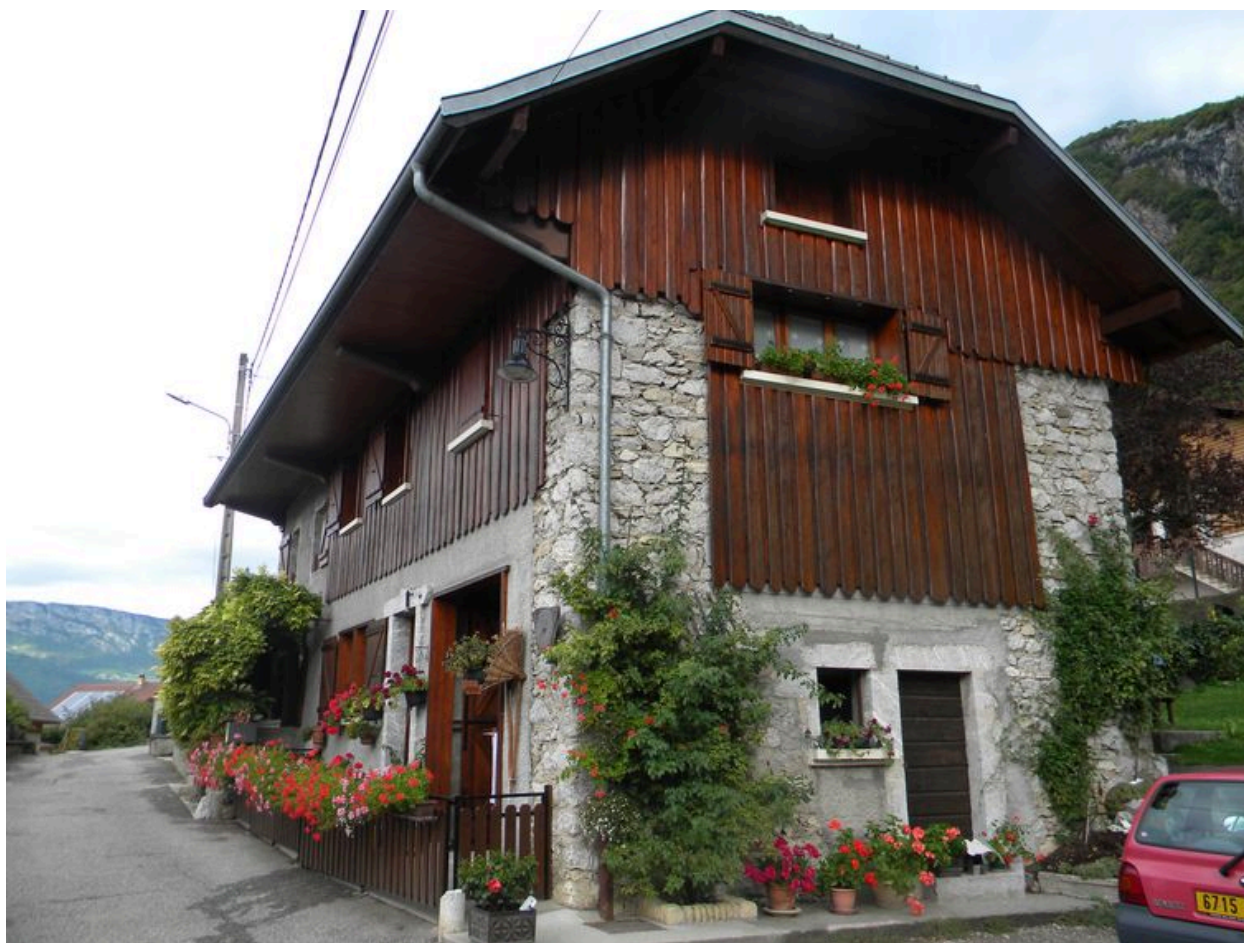
Vue d'une ancienne ferme fortement modifiée. (2008 B4 455).
