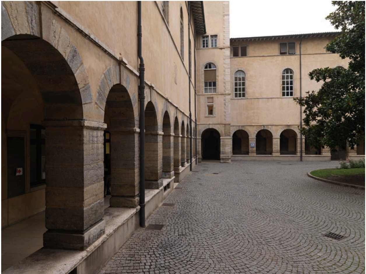
Bâtiments Q à gauche et M au fond ; dans l'angle, la tourelle sud-ouest du dôme des Quatre Rangs
