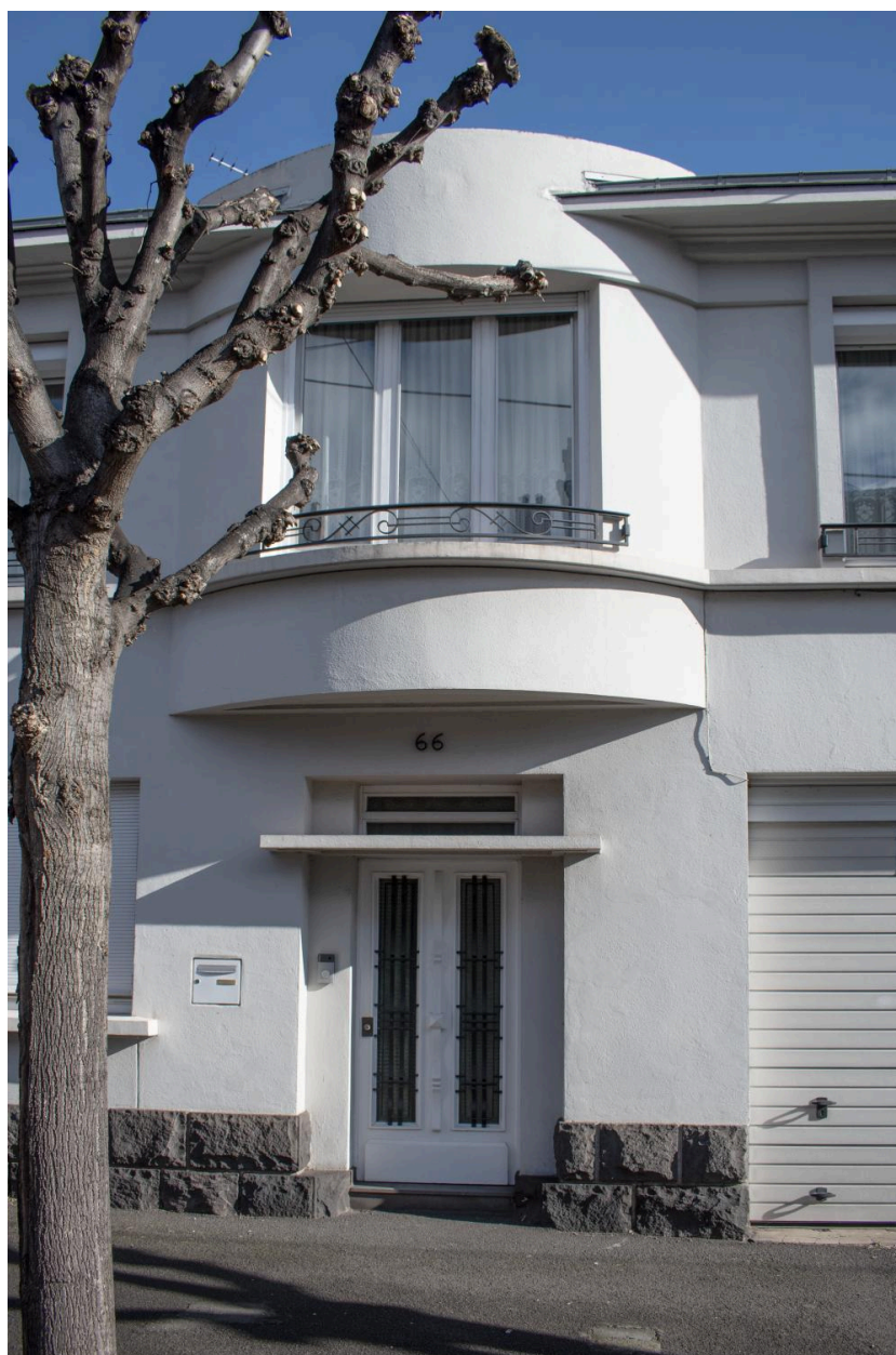
Détail de façade: travée centrale
