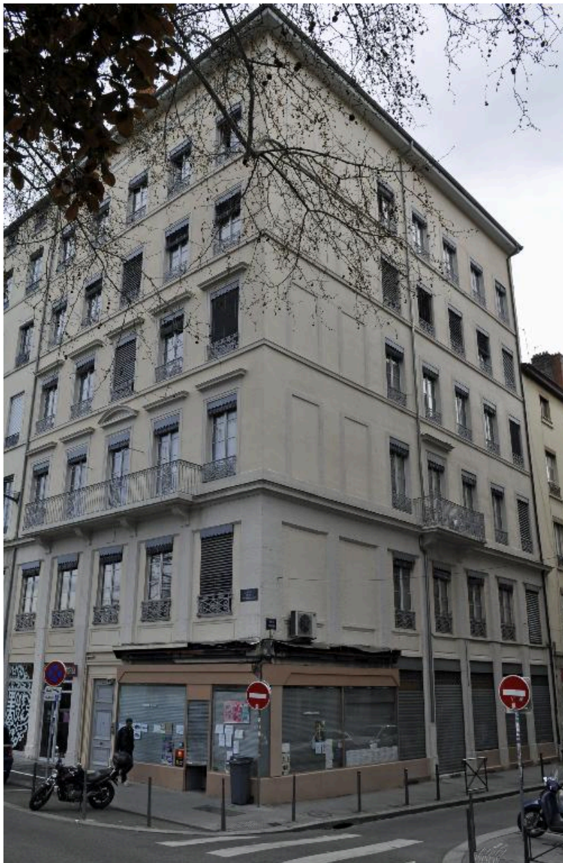
Elévation latérale, rue Passet
