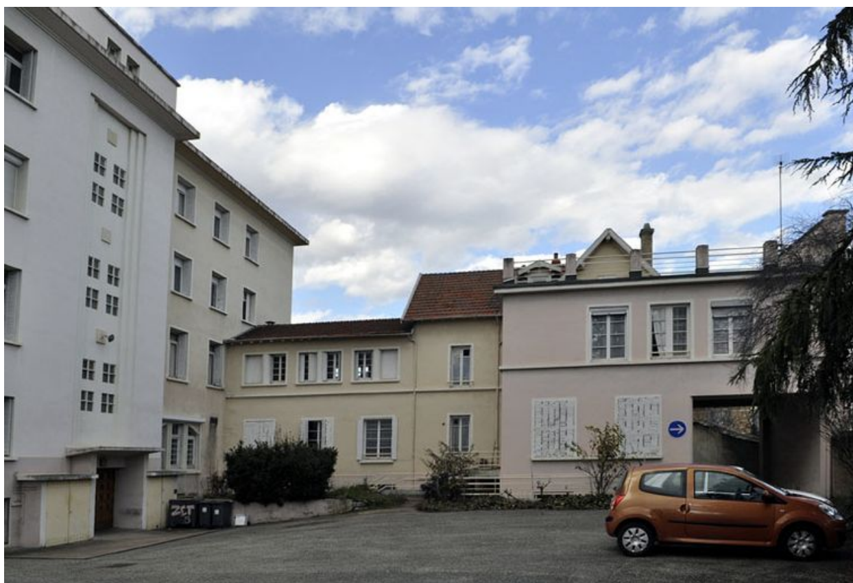
Façade sud (partie)
