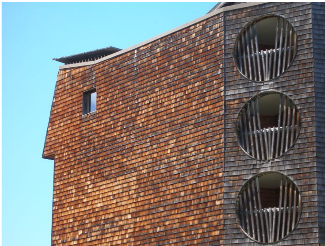
Détail du pignon est
