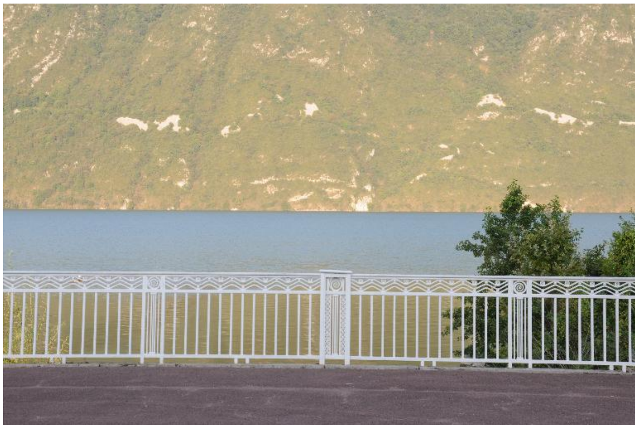
Pont sur le Sierroz : garde-corps en métal
