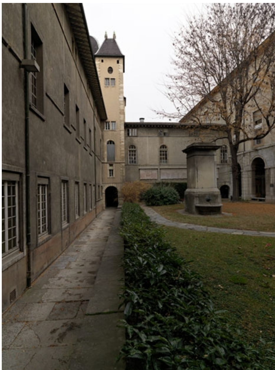
La terrasse le long du bâtiment M rachetant la différence de niveau avec la cour d'Honneur
