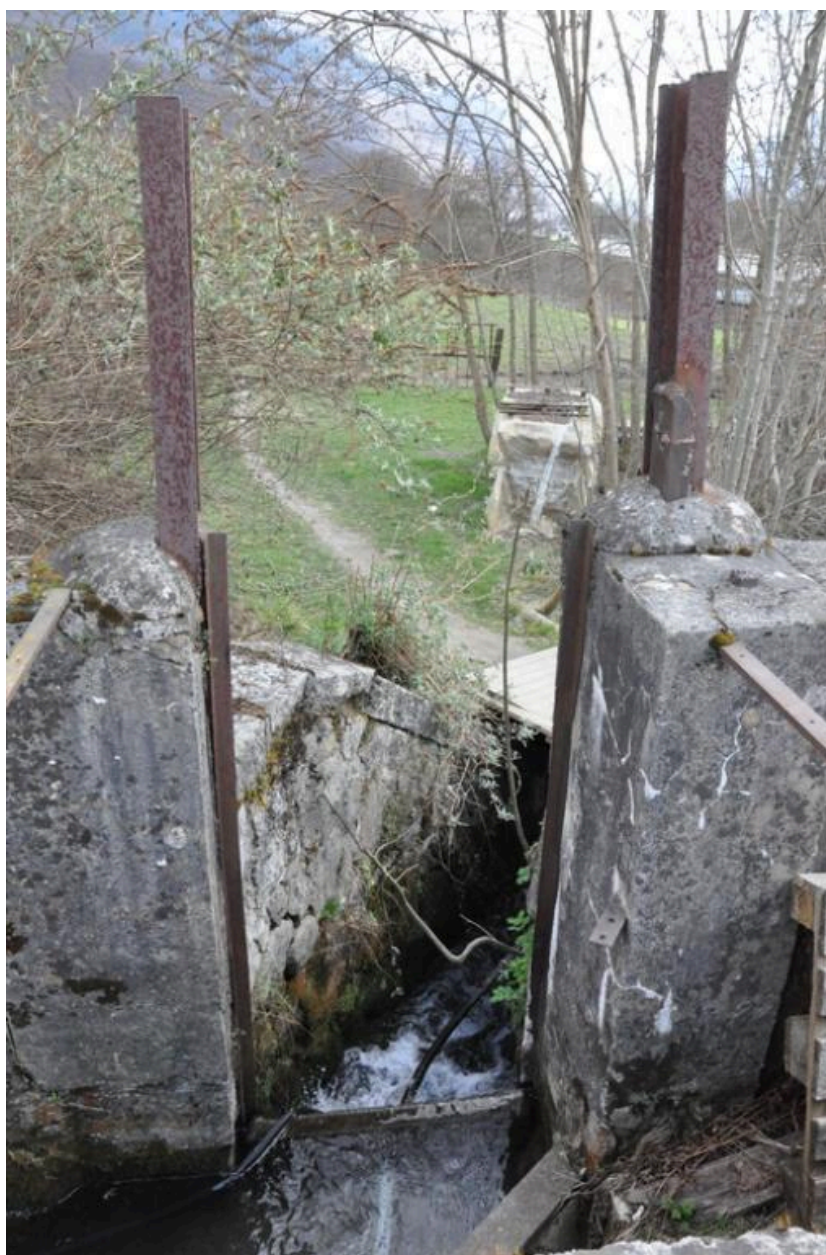
Vue d'une vanne du canal d'amenée.
