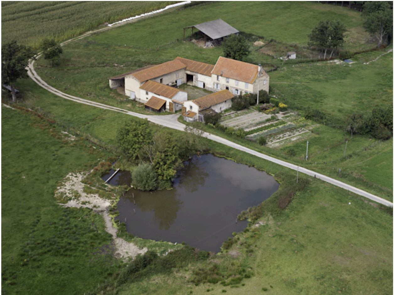
Vue d'ensemble aérienne depuis l'est.
