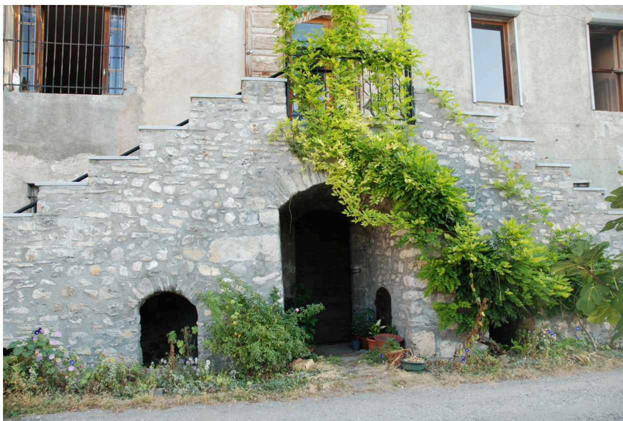
Détail de l'escalier extérieur.
