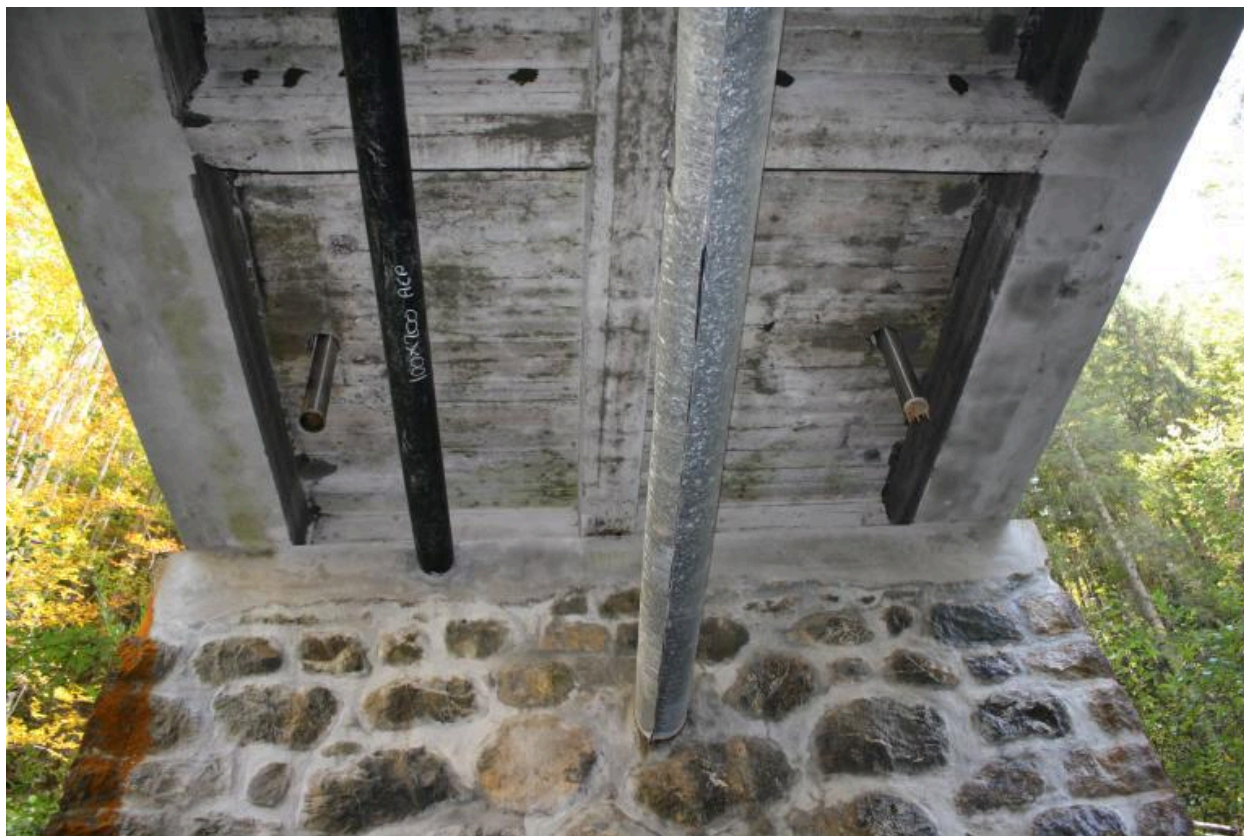
Pont des Onchets, détails culée et tablier
