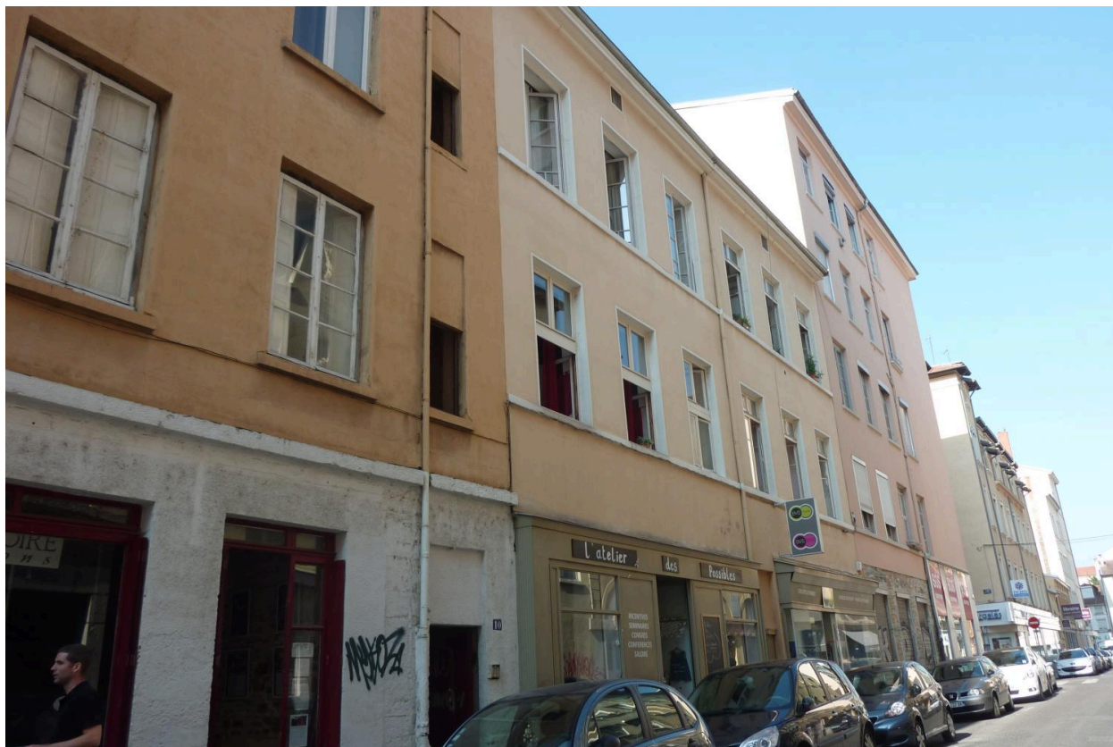
Vue d'ensemble de l'immeuble-atelier
