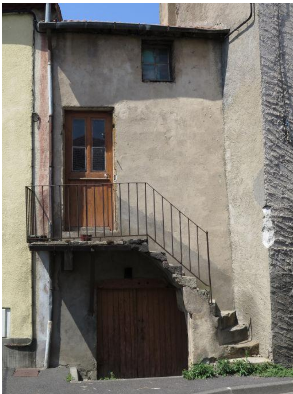
Vue générale : façade principale (sud)
